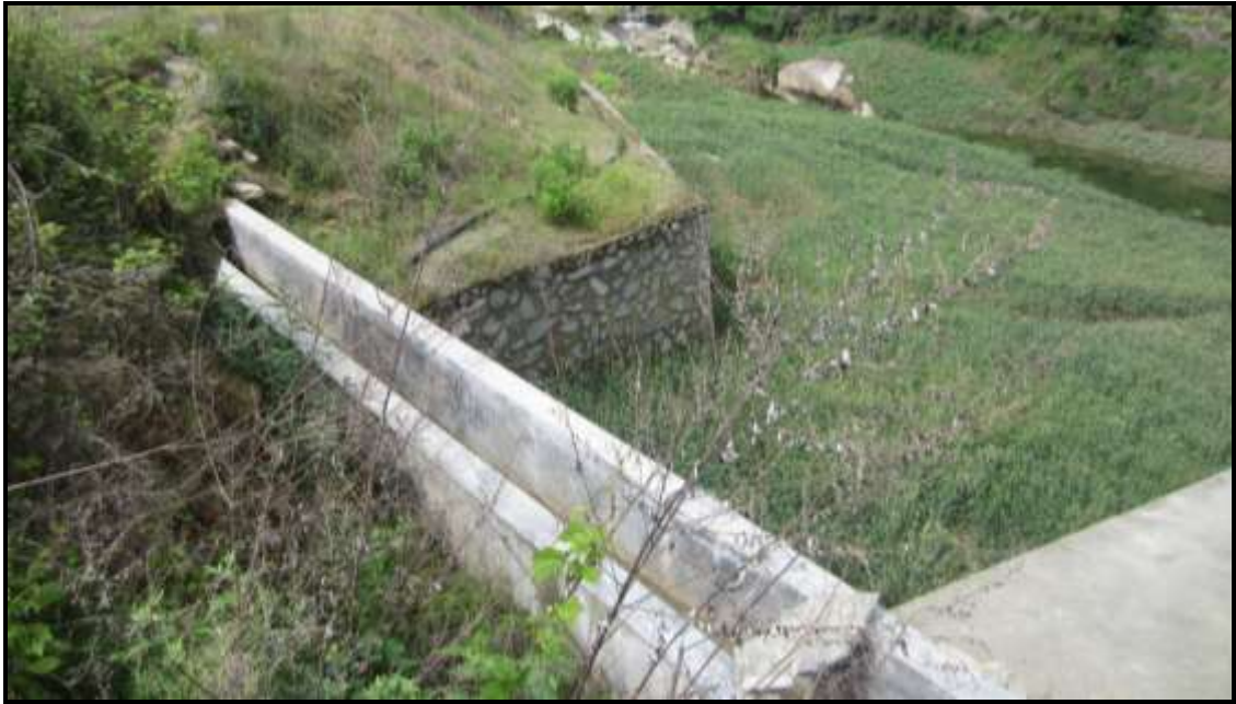
照片 1-5 破碎加工厂外侧的挡墙及排水渠（镜向 NW）
