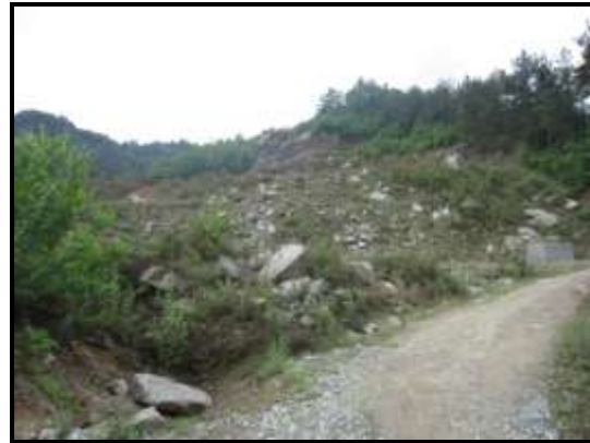
照片 1-2 临时堆渣场（镜向 SW）
