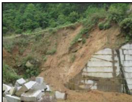
照片 4-1 表土覆盖情况（镜向 S）
