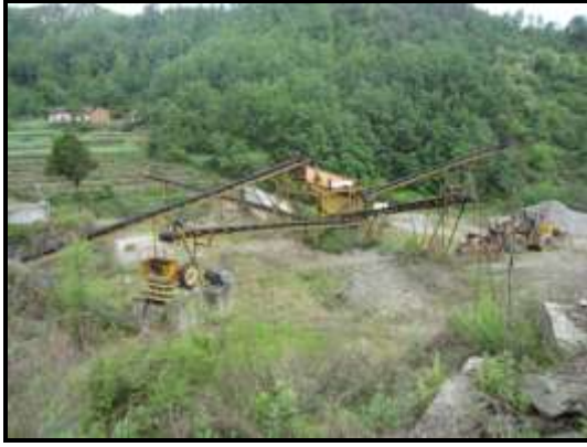
照片 1-3 破碎加工厂（镜向 NE）
